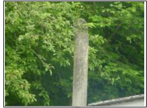
Asbestos flue
