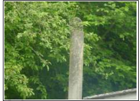
Asbestos Flue
