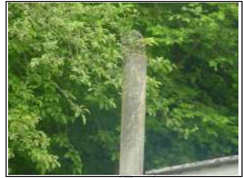
Asbestos flue
